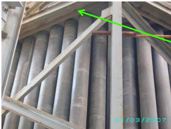
Precipitadores con soporte de tubos colectores en material de acero inoxidable 316L.
